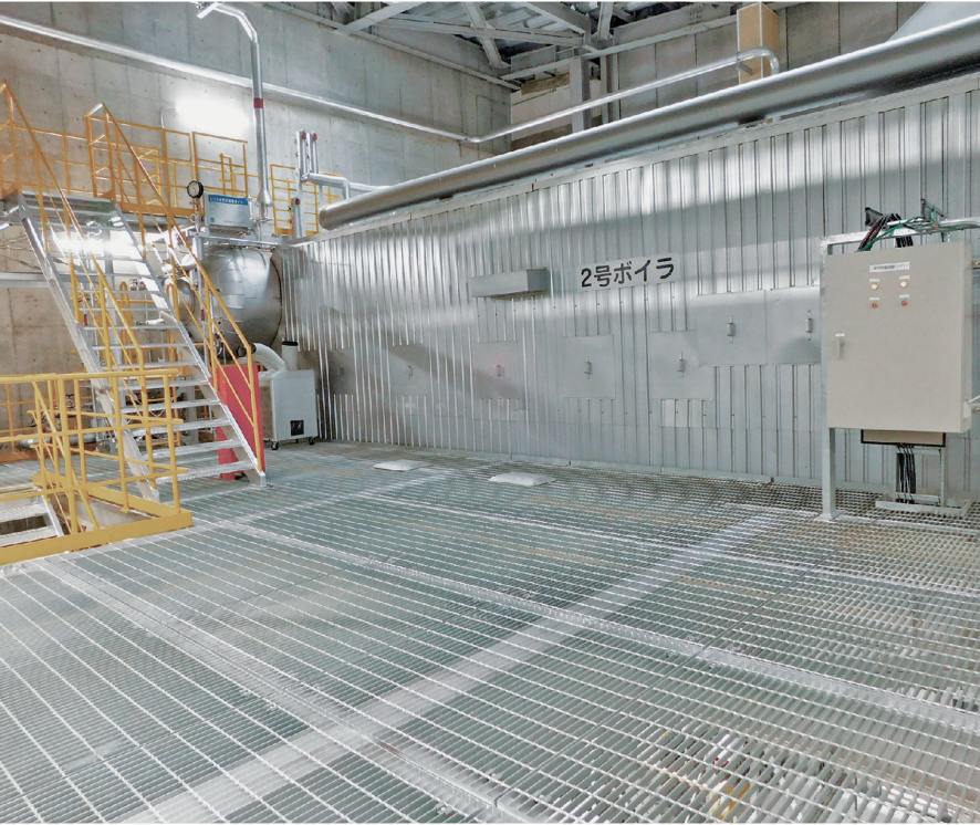
高温高圧ボイラーの採用で、発電効率22.9%を実現
