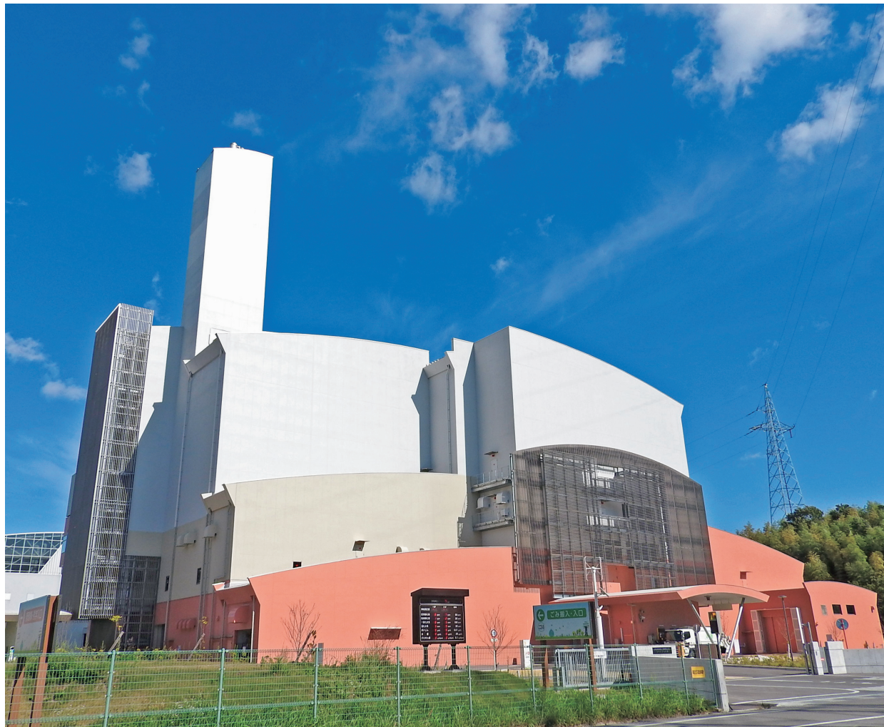
処理能力174t/日のストーカ式ごみ焼却施設で、今年1月に稼働を開始した
